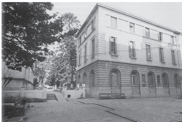
Fig. 2. Uno de los pabellones del viejo Hospital poco antes de su demolición. (Tomada de Pégola F, Sanguinetti F [1998]. "Historia del Hospital de Clínicas".)
