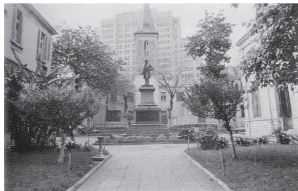
Fig. 3. Patio central del viejo Hospital de Clínicas con el monumento de Ignacio Pirovano. (Tomada de Pégola F, Sanguinetti F [1998]. "Historia del Hospital de Clínicas".)
